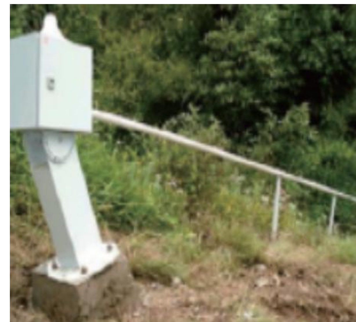
地表裂缝监测
