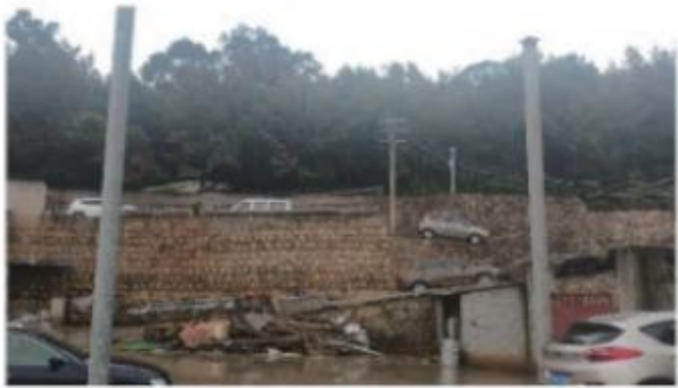
机修厂生活边坡
